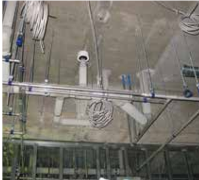
集合住宅の給排水工事
