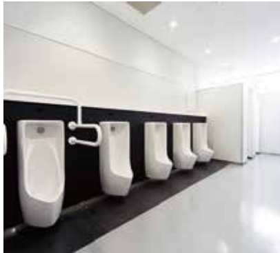
衛生器具取付
