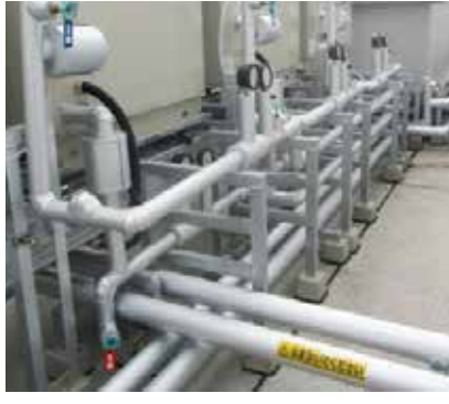
給排水工事配管
