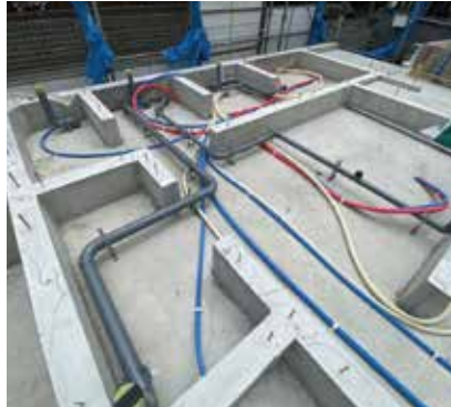
一般住宅の給排水工事
